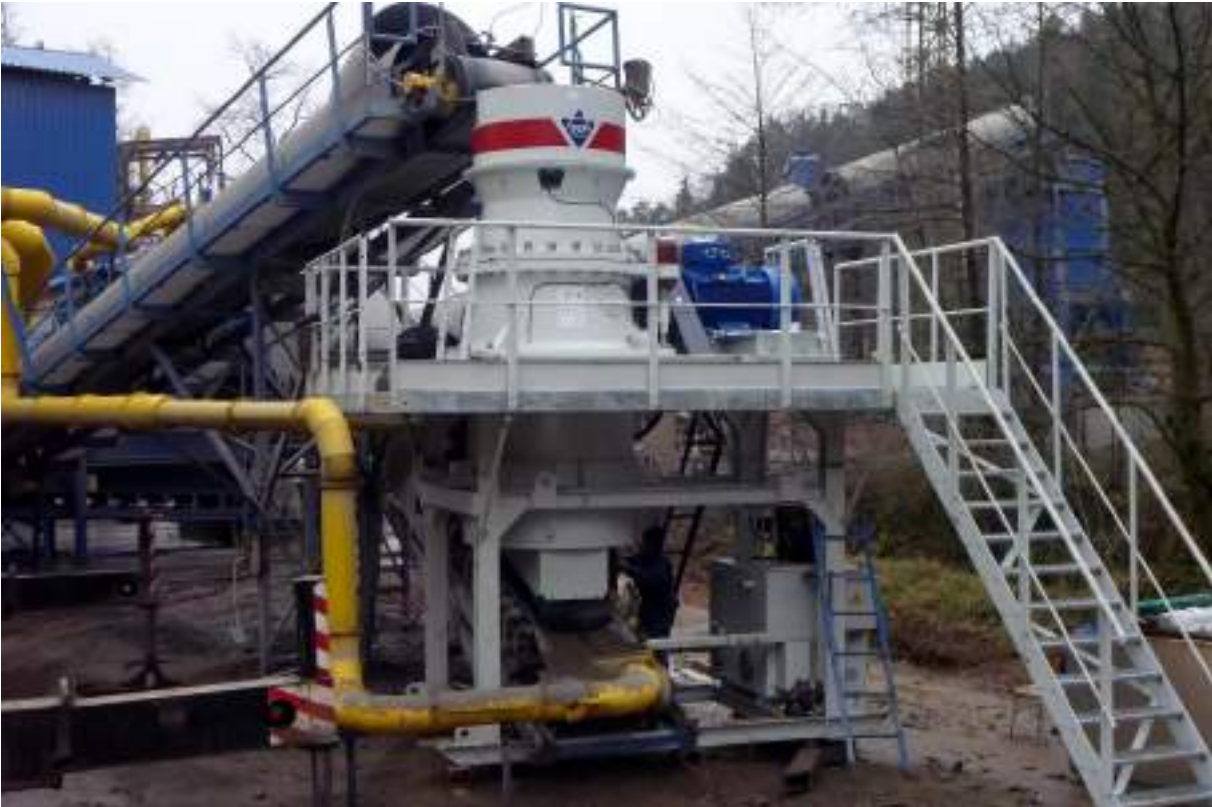
M-Silnice a.s. Hradec Králové – quarry Žumberk (Czech Republic) – cone crusher HCU 9/250
