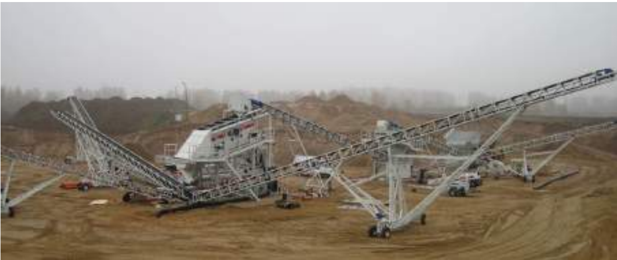
MIŠKINIŲ KARJERAS (Lithuania) – Gravel sand processing plant 250 tph
